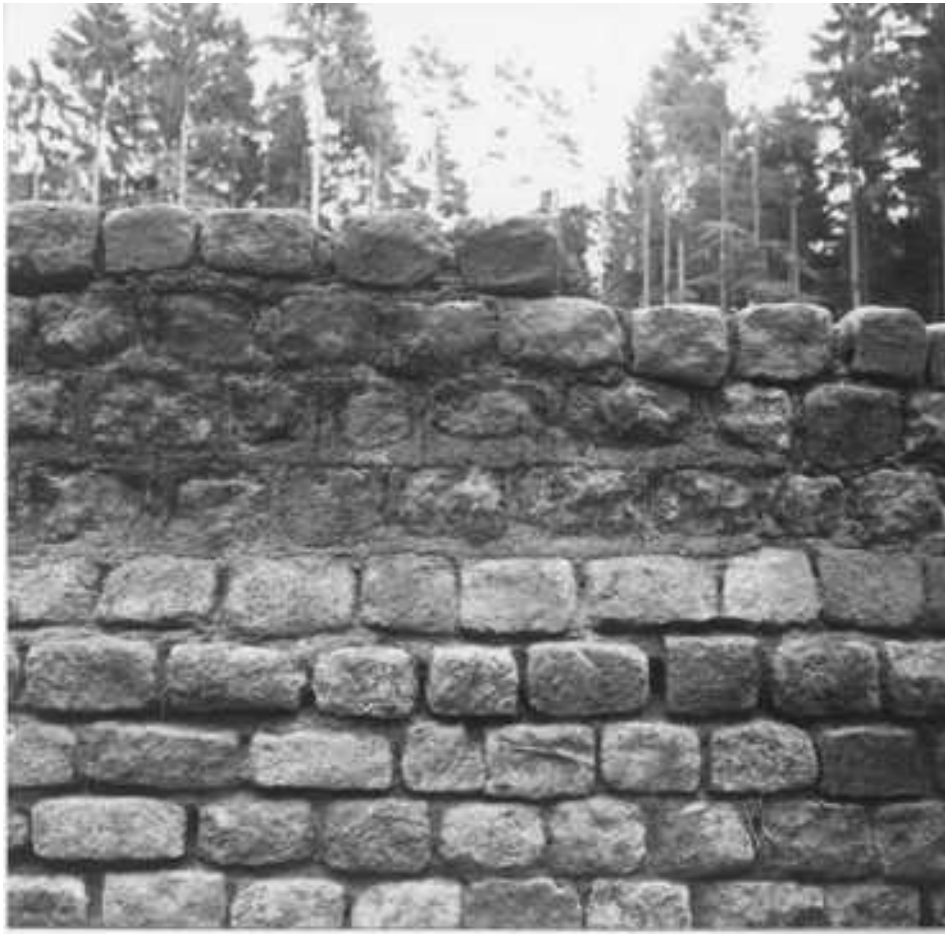
Abb. 7. Hechingen-Stein. Mauer 37 mit Resten von Fugenstrich.
