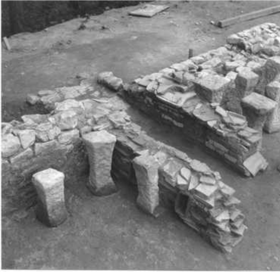
Abb. 45. Hechingen-Stein. Badegebäude, Heizkanal 465. Blick von Nordwesten.
