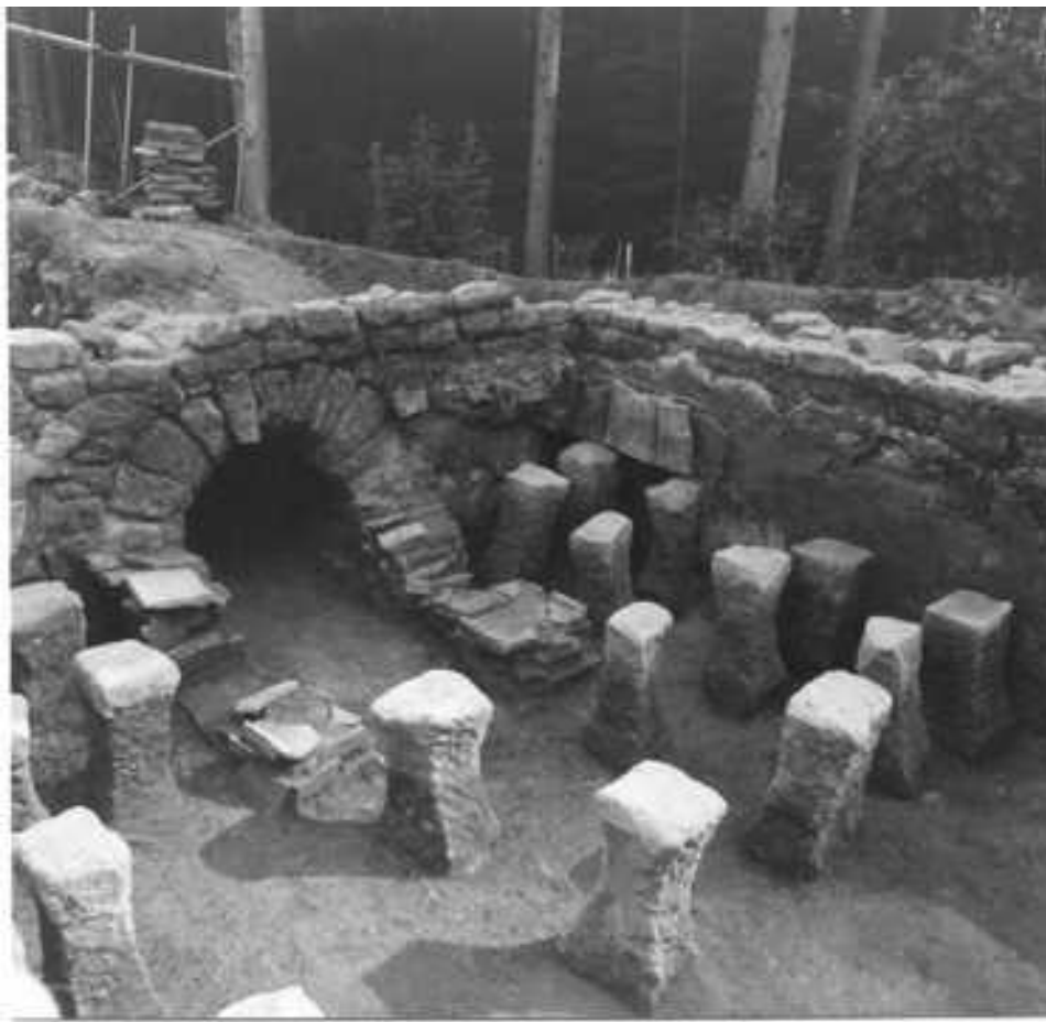
Abb. 48. Hechingen-Stein. Das Badegebäude. Caldarium (2) mit dem Heizkanal (444). Blick von Südwesten.
