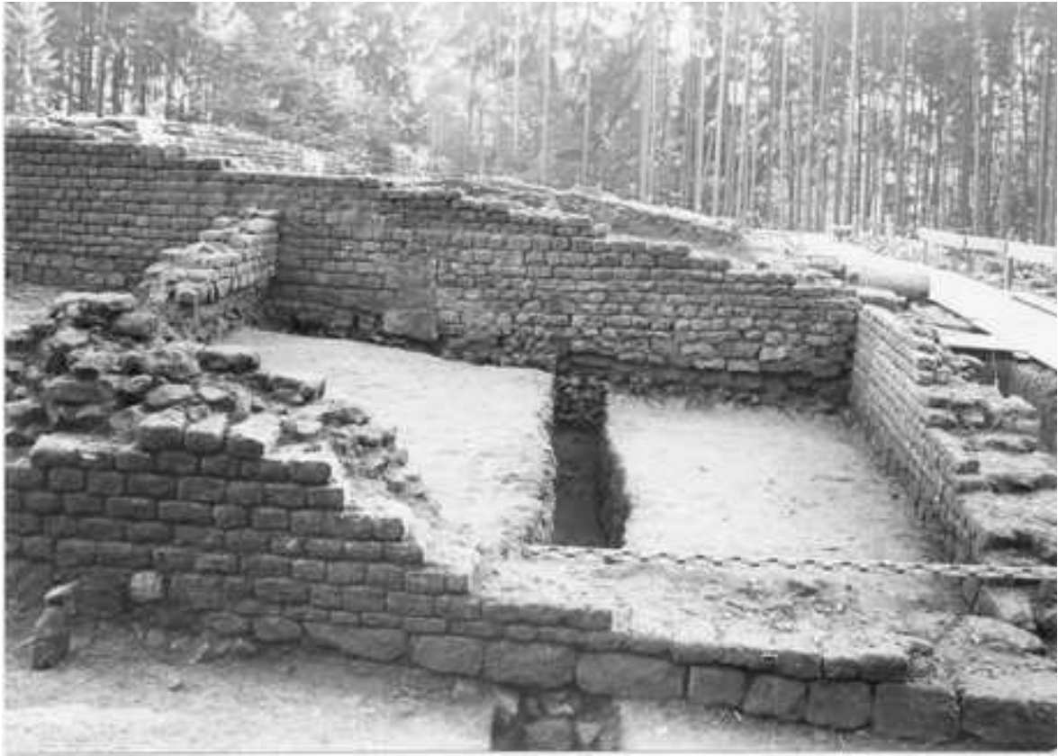
Abb. 26. Hechingen-Stein. Blick in den westlichen Eckrisaliten 11. Deutlich sichtbar ist die Fuge zwischen der älteren Mauer (37) und der angebauten Mauer (57). Blick von Westen.
