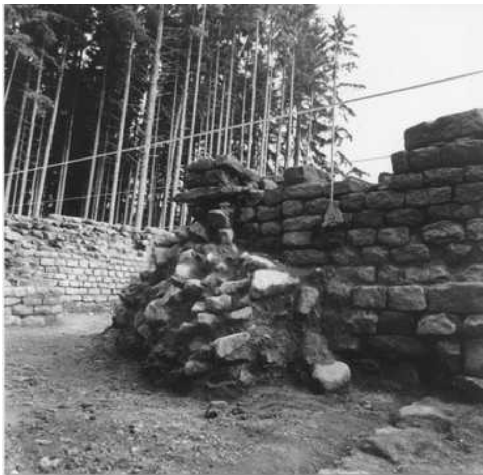
Abb. 57. Hechingen-Stein. Nachrömisches Trockenmauerfragment (53). Blick von Süden.
